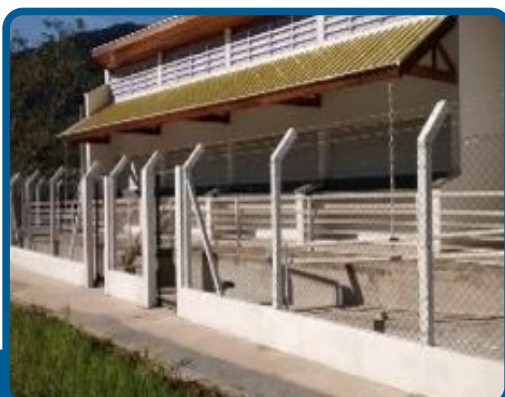
Construção de boxes para comercialização de pescado
