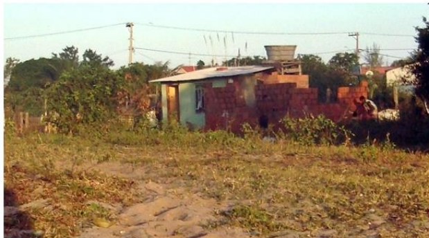
Construções irregulares em agosto de 2013, em área de preservação ambiental.
