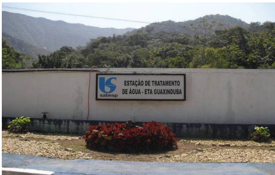
Figura XI.2-3 – Vista geral da ETA Guaxinduba.
