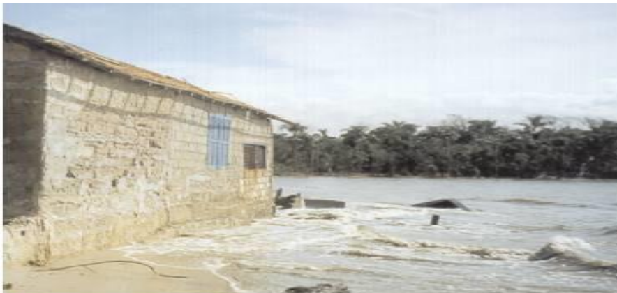
Figura VII.4.1.1-6 – Processo de inundação e erosão na foz do Juqueriquerê.
