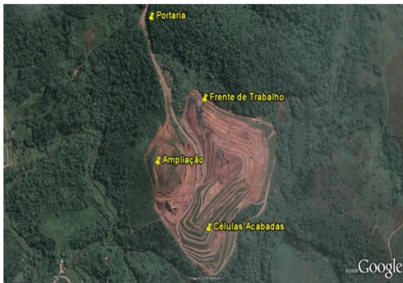
Figura XI.2-9 – Vista Aérea do Aterro Controlado no município de Santa Isabel.
