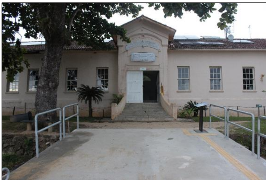
Figura VI.3-1- Prédio da administração do PEIA, antigo prédio administrativo do presídio.
