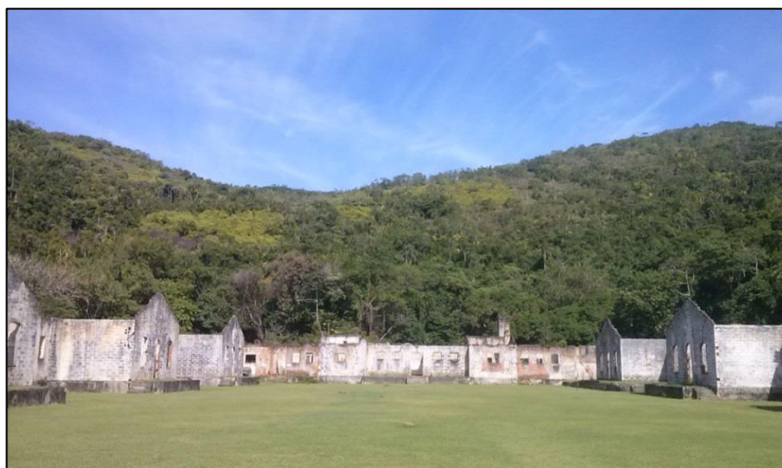
Figura VI.2.8-1- Vista das Ruínas do antigo presídio.
