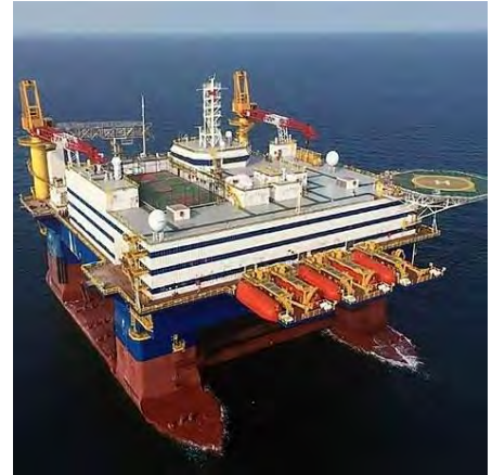
Unidade de Manutenção e Segurança (UMS). Lagoa de Imboassica - UMLI
