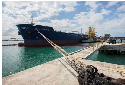
Bases de apoio marítimo
