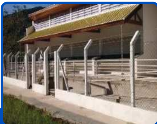
Construção de boxes para comercialização de pescado
