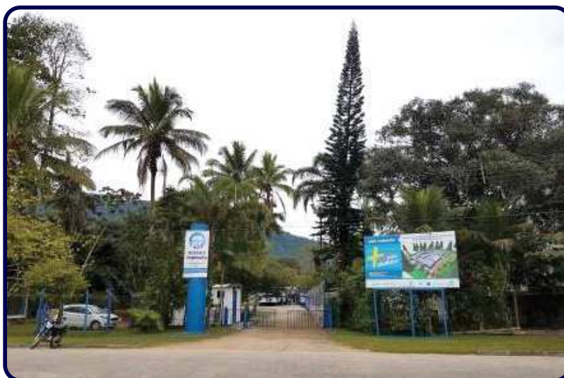
Centro de Reabilitação e Despetrolização de Ubatuba
