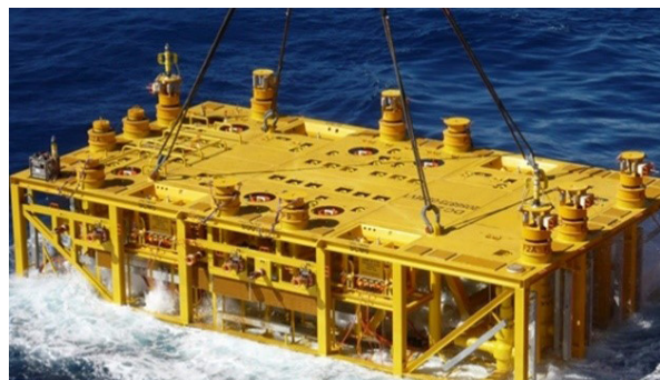
Imagem 24: Instalação dos manifolds
