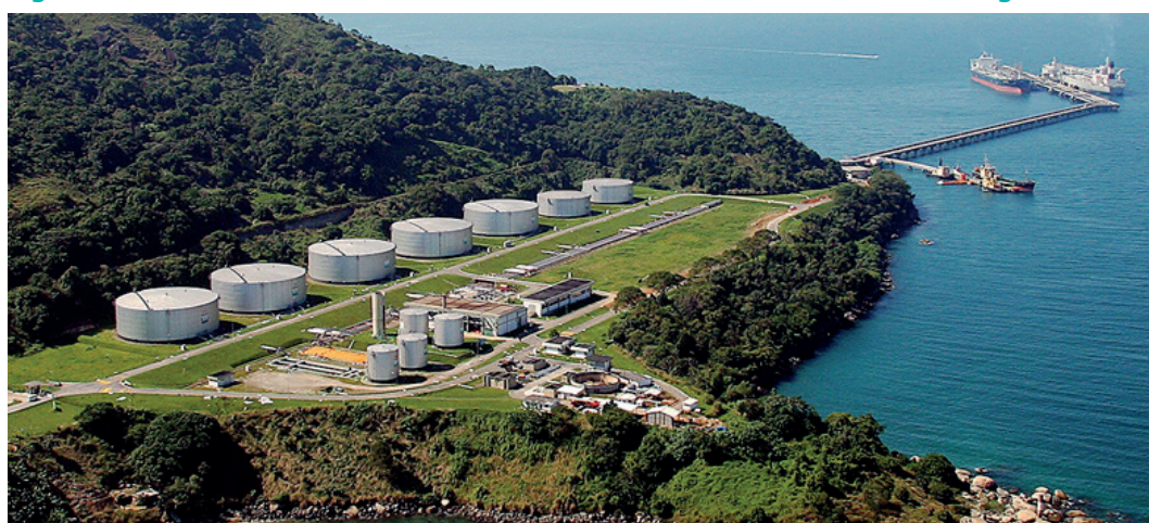
Imagem 19: TEBIG - Terminal Marítimo Almirante Maximiano da Fonseca, em Angra dos Reis/RJ
