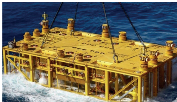
Imagem 24: Instalação dos manifolds
