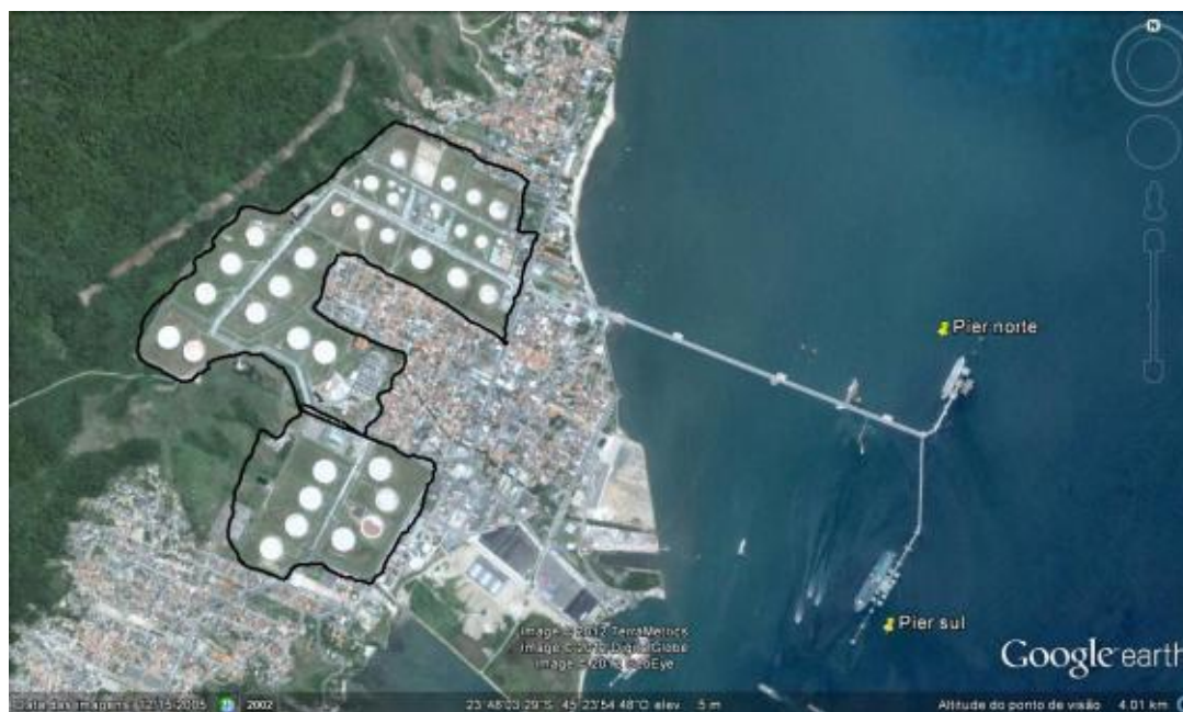
Figura IV.4-1 – Terminal Almirante Barroso – TEBAR com indicação do píer norte e sul e destaque dos tanques de armazenamento. Fonte: Google Earth (set/2012).
